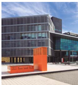
Andalucia-teknologipark. Kontorer med høy energieffektivitet. Spania. ECOi
