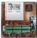
LBA-kontroll. Styrekort, strømtransformator, koblingssplint.
